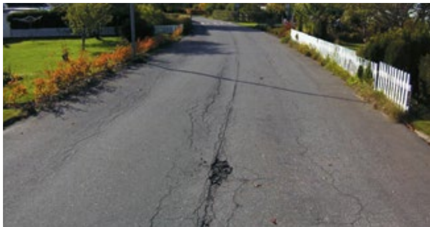
Bild 1. Exempel på en gata med akut underhållsbehov.
