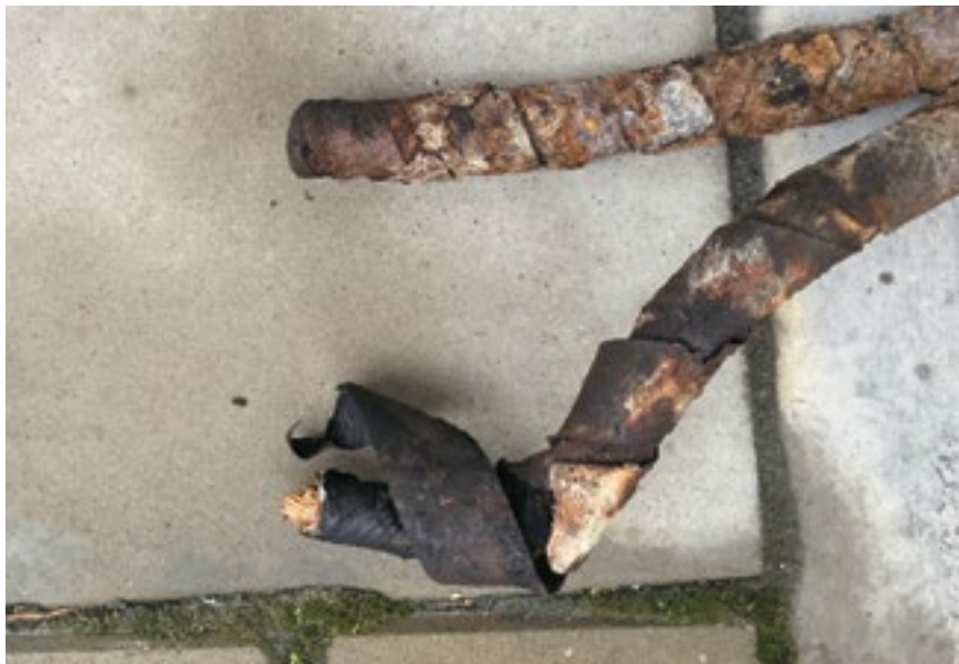
Bild 6. En enfas järnvägs kabel som har bytts ut.
