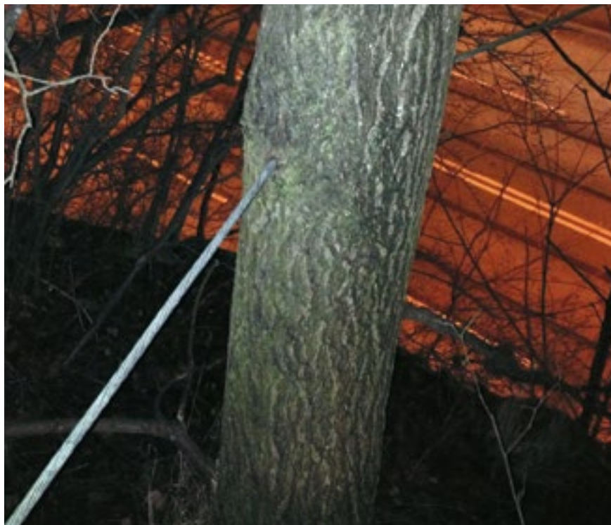
Bild 7. En från början liten och klen stam har under många år gnagt på en vajer för linhängda armaturer och så småningom har vajern vuxit in i trädet. Slänten där trädet växer är något otillgänglig, därav den bristande tillsynen.
