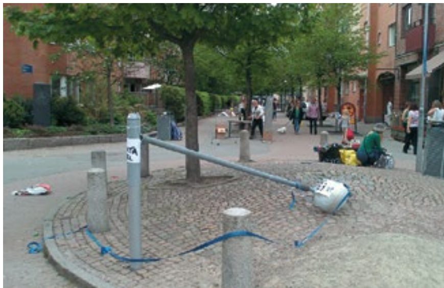
Bild 11. Resultatet efter att en banderoll fästs mellan två belysningsstolpar en blåsig dag. Stolparna är inte dimensionerade för denna extra last.
